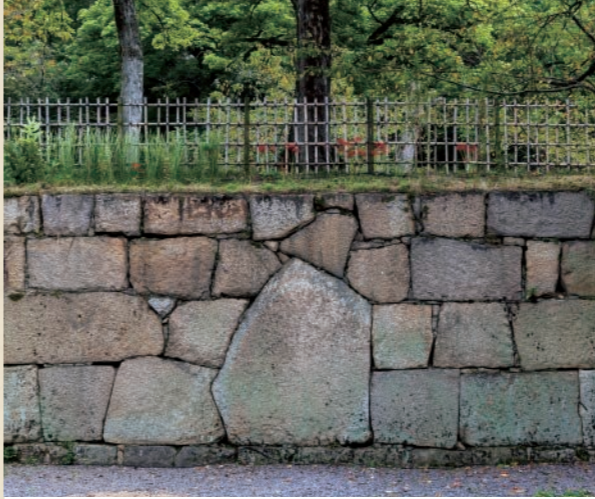
【切り込みハギの石垣】 中央が鏡石。巨石を運んで加工し、隙間なく積み上げるには、技術も財力も必要だ。
