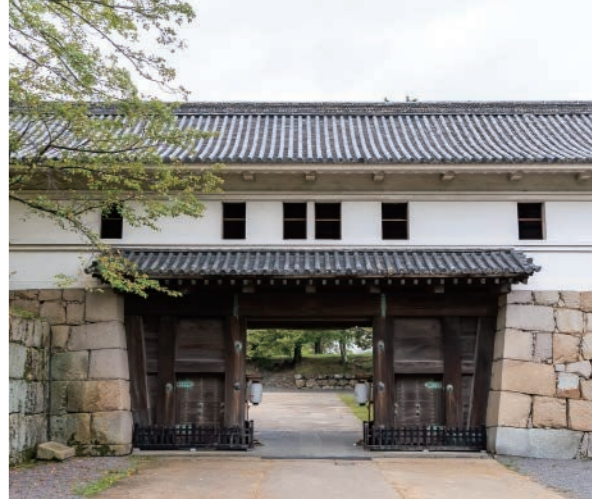
大手一の門。門の上部のやくらで、現在も刻を告げる太鼓を鳴らしている。
